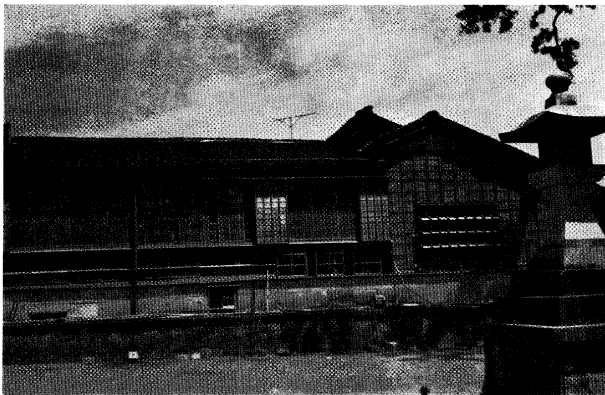
南側外観 左から酒造倉蔵前2階部分ルーバー状の庇のある大窓，正面道路と続く
