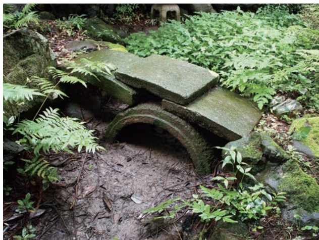
図-6 細い流れに掛かる井戸側を利用した石橋
