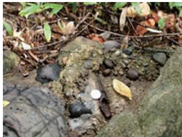
図-5 滝組上部 鉄管の露出 コインは100円玉
