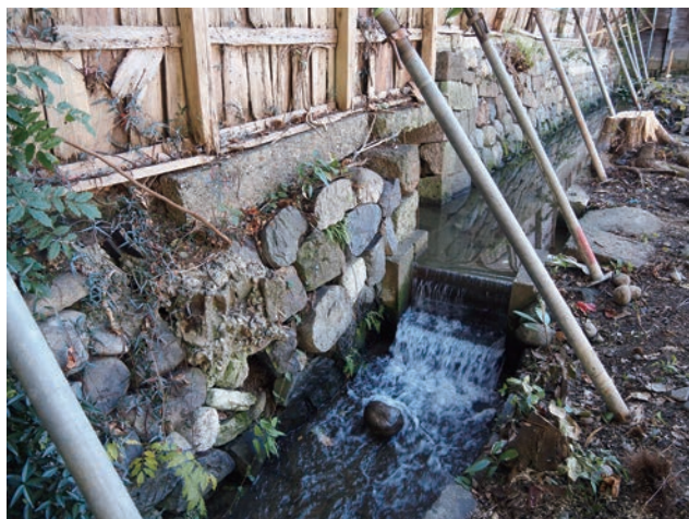
図-4 農業用水に設けられた角とし堰
