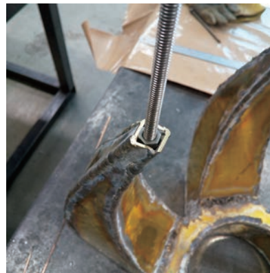
30. 今回は野外での設置であり、コンクリート部分に強く固定するため、ナットを溶接する。
