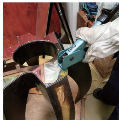
40. ステンレス板の下穴をガイドに真鍮に穴を開けながらブラインドドリットで留めていく。
