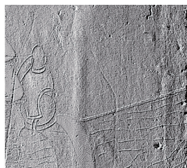
B5-S2 側光線合成写真： 突き跡、引っ掻き傷が見える。幅広い棒継ぎが縦に走っている。
