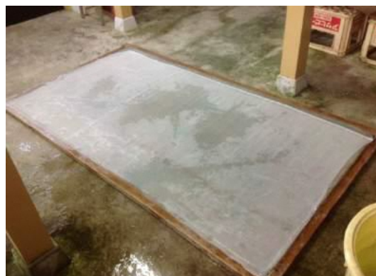
床に寝かせた桁の上に寒冷紗を敷き、水で濡らす
