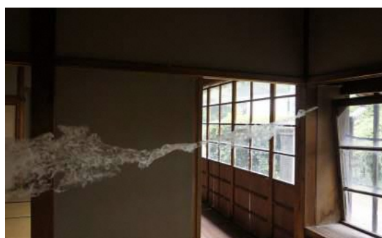
窓の隙間付近
