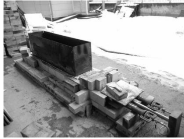
鉄板の箱を土台の上に置く
