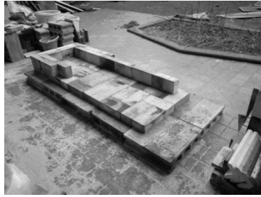
耐火レンガで側面を築く
