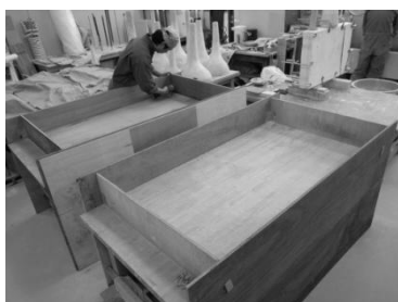
ベニヤ板で壁をつくる
