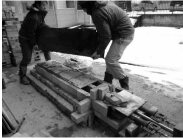
鉄板の箱づくり
