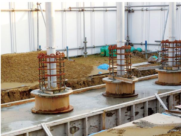
図26 基礎及び土台部分〈施工：(株)山森工業〉
