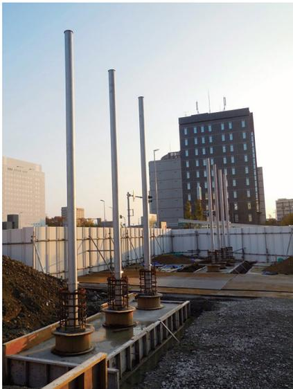
図25 基礎及び土台部分〈施工：(株)山森工業〉
