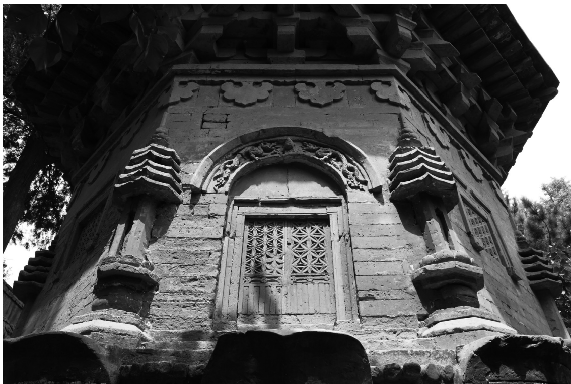
図12-2 同 第一層塔身 門扉および宝塔
