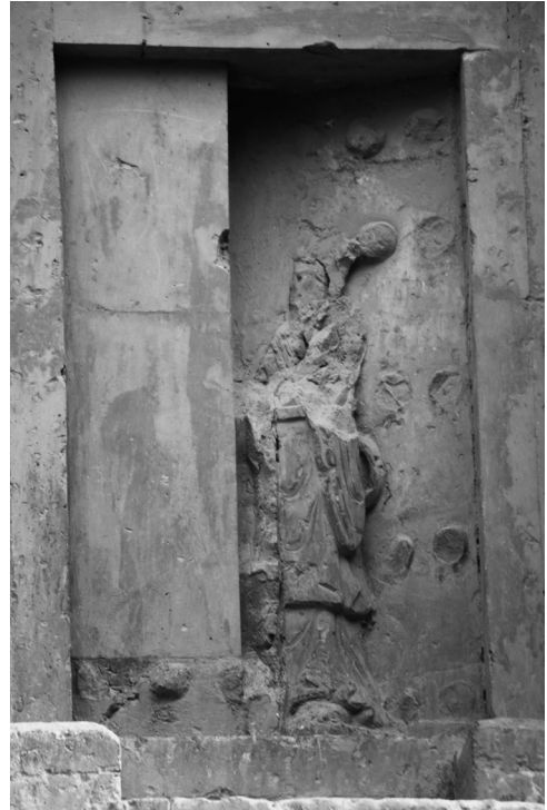
图10-4 同 塔身北面門扉部分
