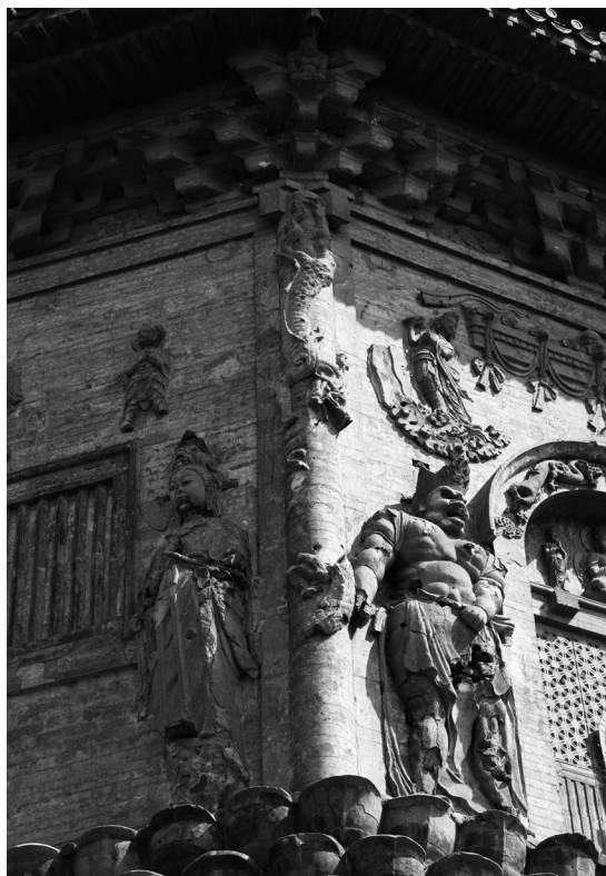
図1-2 同 塔第一層塔身隅柱 南面・西南面
