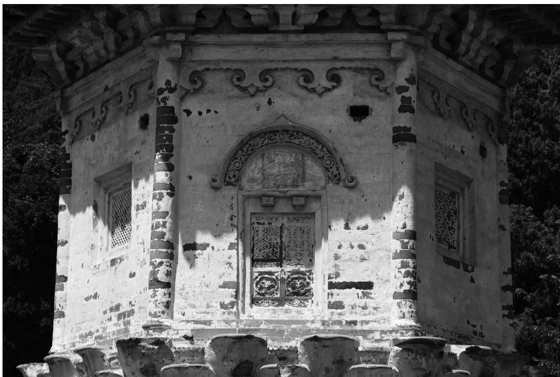
図20-2 円通塔大禪師扇公靈塔 第一層塔身 南面
