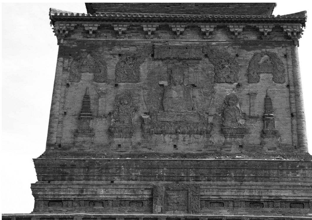
図1-3 朝陽北塔 第一層塔身 西面
