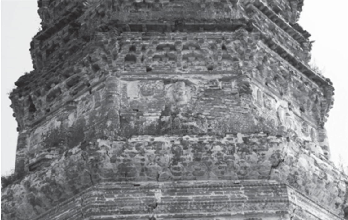
图5-6 同 第一層塔身 西北面
