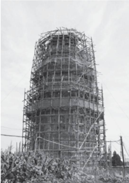
図7-1 塔萱子塔（修理の様子）
