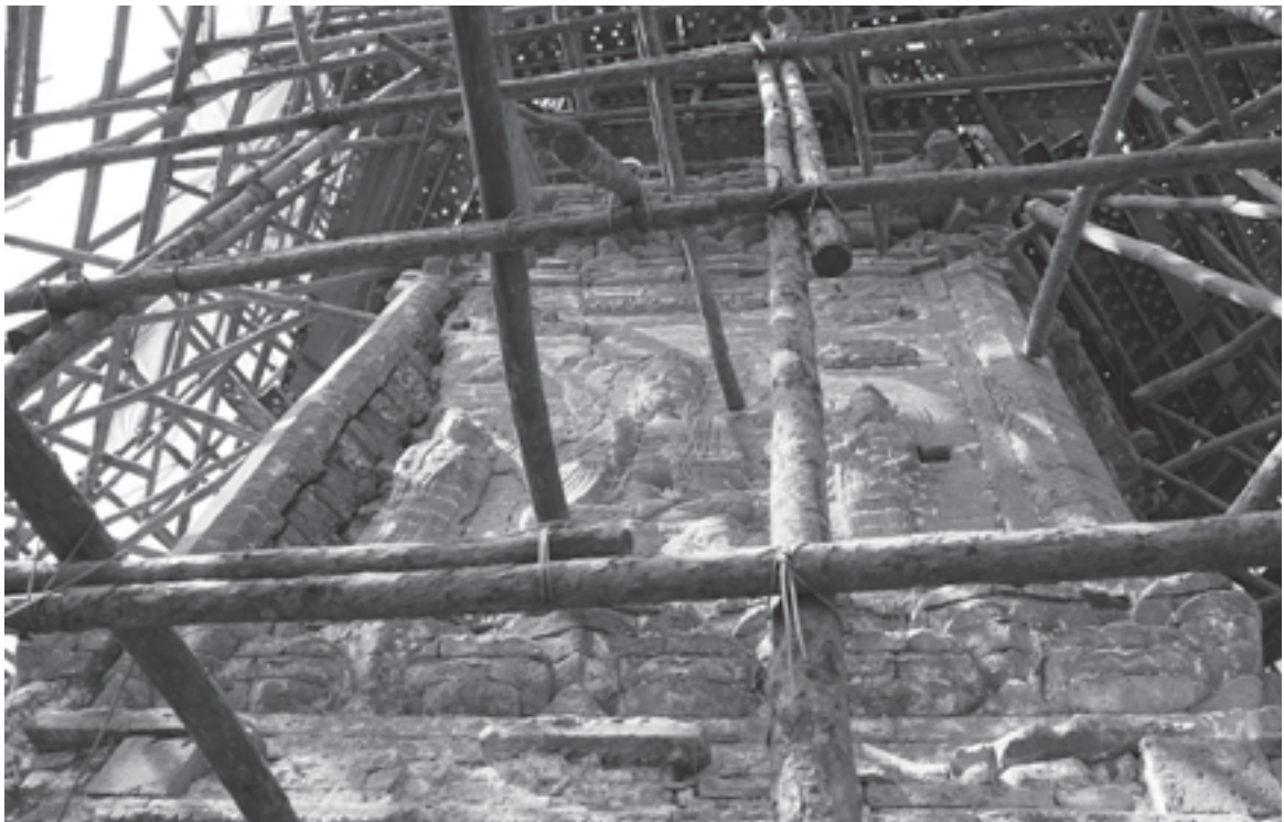
图12-2 同 第一層塔身 東南面
