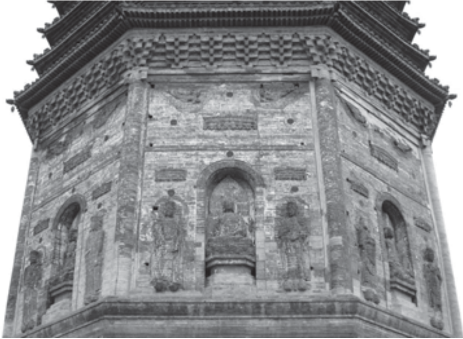
图10-4 同 第一層塔身 西面
