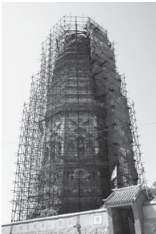
図8-1 広勝寺塔（修理の様子）
