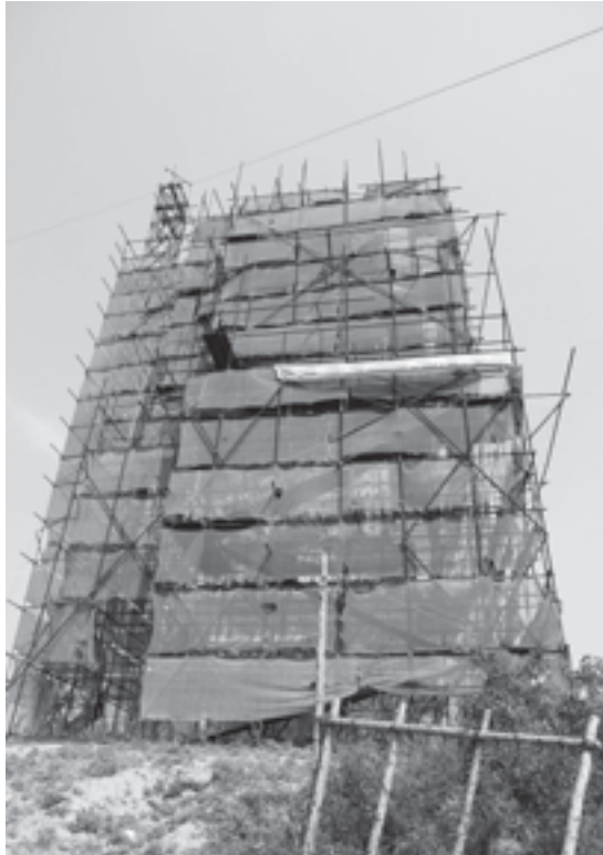
図4-1 青峰塔（修理の様子）
