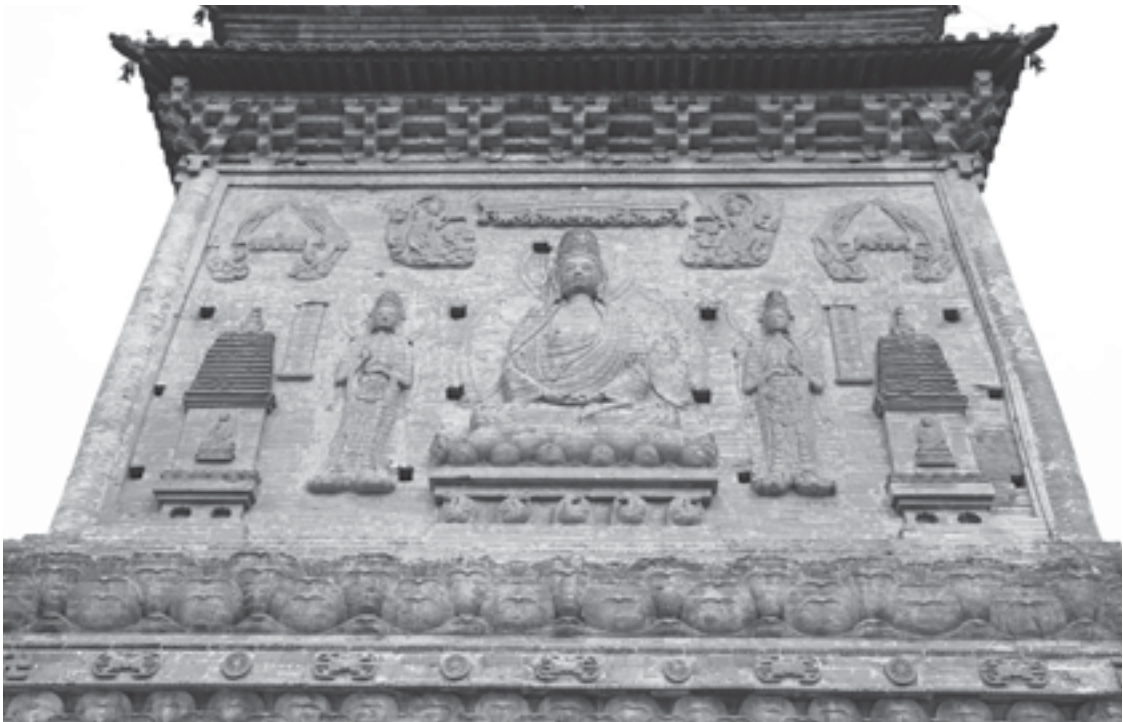
图2-3 同 第一層塔身 西面
