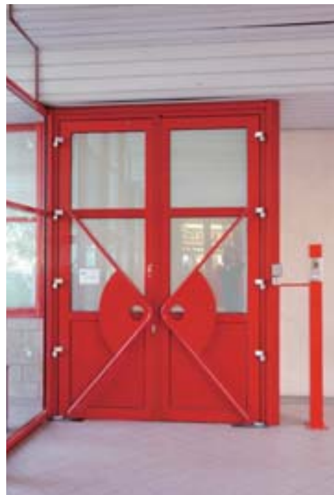
内部の様子が見えないセキュリティ対応の扉になっており、右側に鍵がある。
