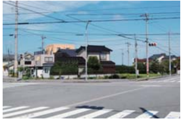
1) 現状から看板面をすべて消去
