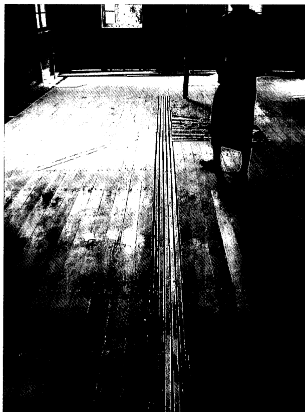
張り直した床と通気のためのスリット
