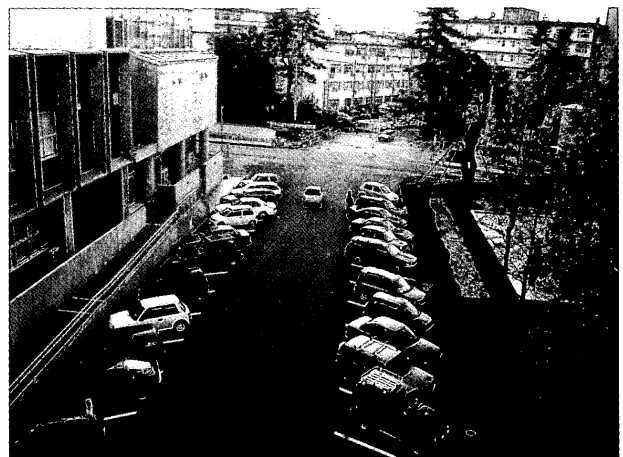
図-4 正面アプローチ現況
