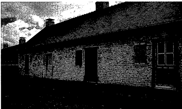
図13 旧労働者住宅
